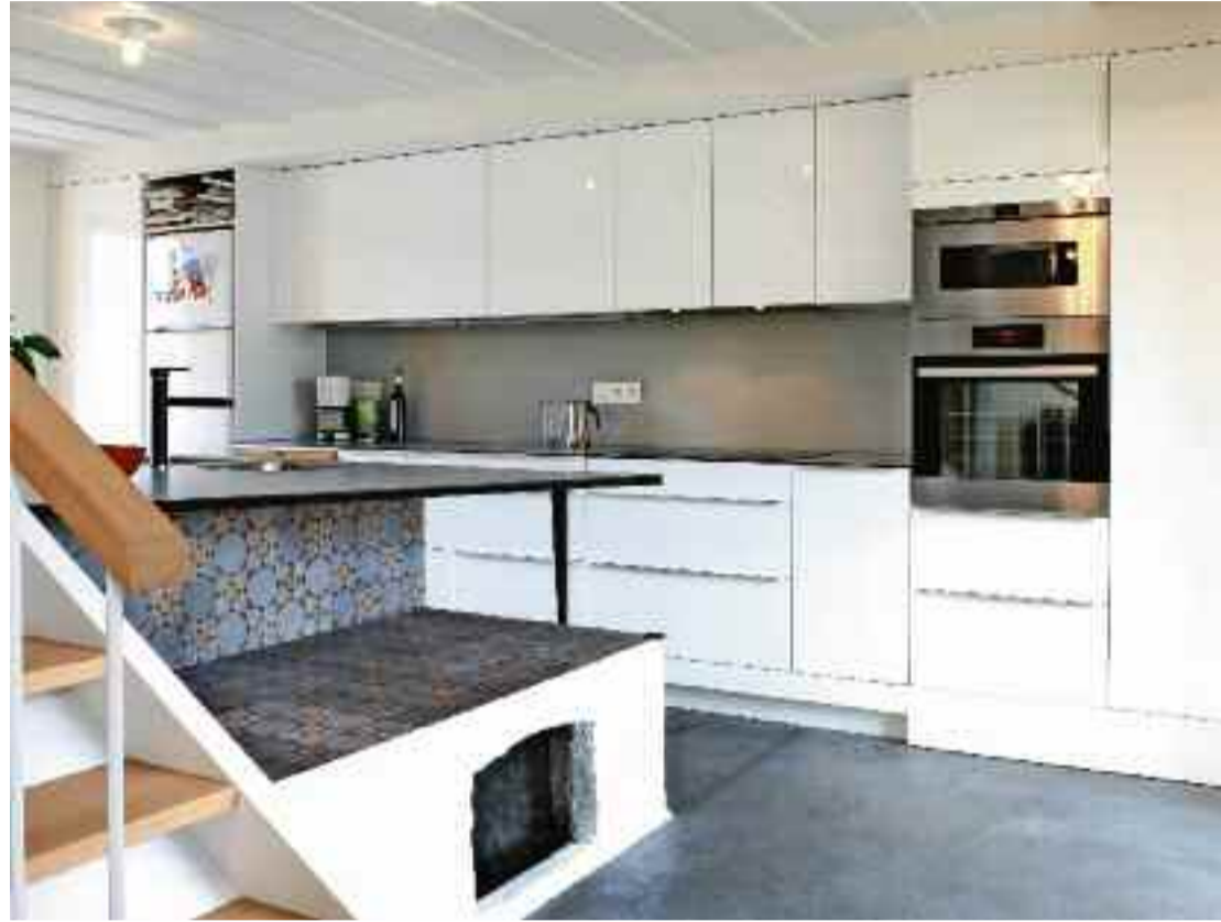
Het keukeneiland is bovenop de oude kelder geïnstalleerd. De cementtegels zijn gerecupereerd. Het authentieke raampje toont aan tot waar het oorspronkelijke huis kwam. Foto's Eddy Vangroenderbeek
